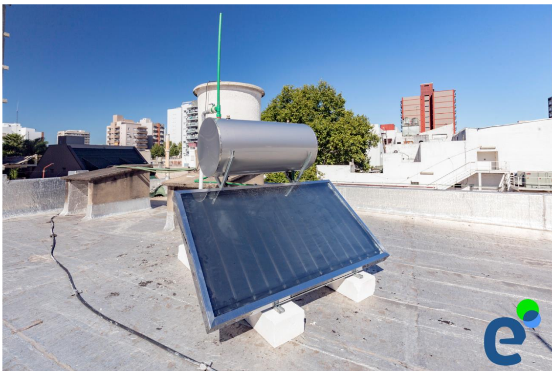
Termotanque solar instalado en la oficina comercial "Tres de febrero"
