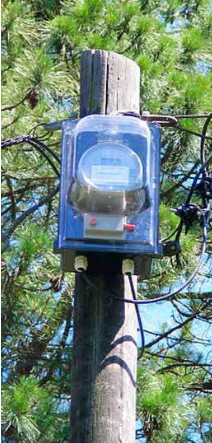
Medidor inteligente en el Delta del Paraná.
