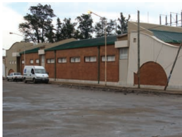
Nueva Subestación Luzuriaga.
